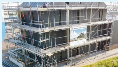
De bouw van het hotel vordert gestaag.
